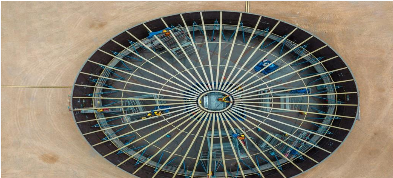
Tanques armazenamento combustivel A. Internacional Lima/ Perú
