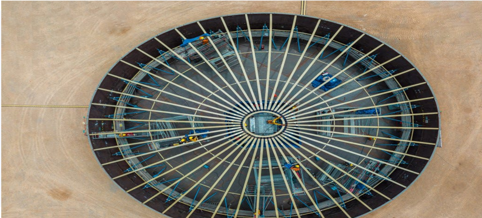
Tanques armazenamento combustivel A. Internacional Lima/ Perú
